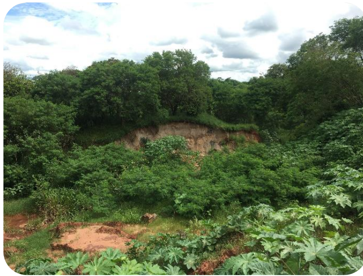
Figura 27 – Voçoroca a jusante da nascente do Córrego Cumandaí Fonte: Valenza, 2018
