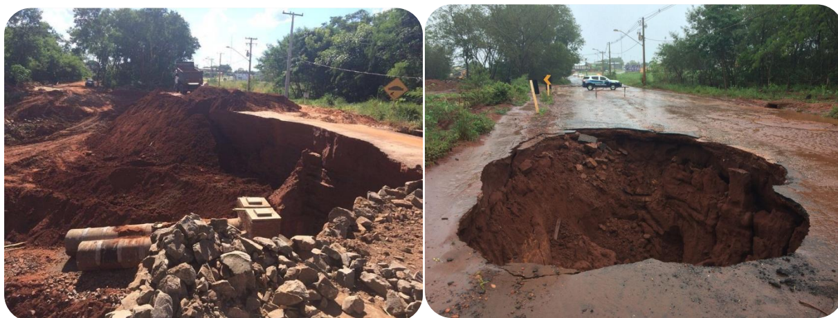
Figura 45 – Canalização do córrego Cumandaí na Av. Weimar Torres (2016) e cratera aberta após forte chuva (2017)
